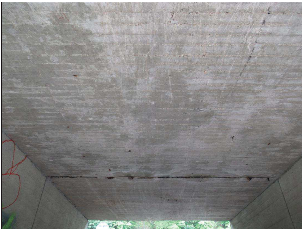
Obr. č. 7 - pohled na spodní líc nosné konstrukce (viditelné lehké průsaky v dilatační spáře, rozdělující objekt na levou a pravou část ve SS a NK)
