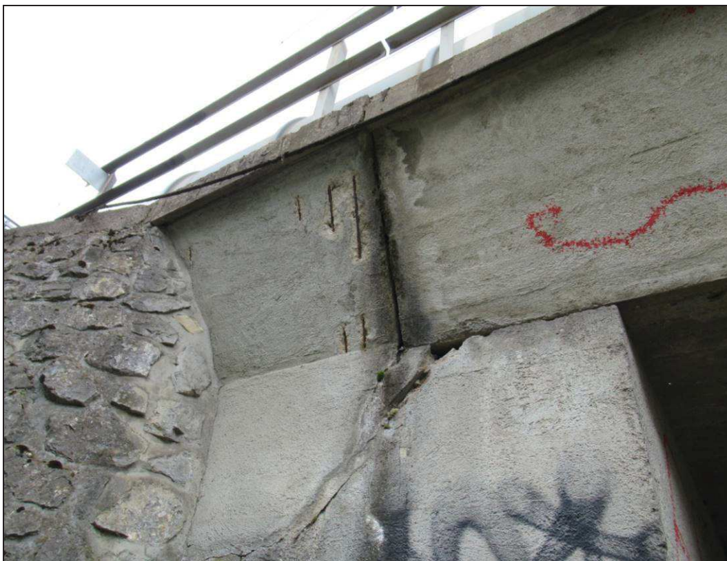
Obr. č. 8 – detailní pohled na dilatační spáru mezi pravou částí NK a opěrou v místě závěrné zídky. Zde dochází k průsakům, opadům a korozi betonu opěry s oprsky krycí vrstvy betonu nad výztuží. Odhalená výztuž je celoplošně postižená povrchovou korozí.
